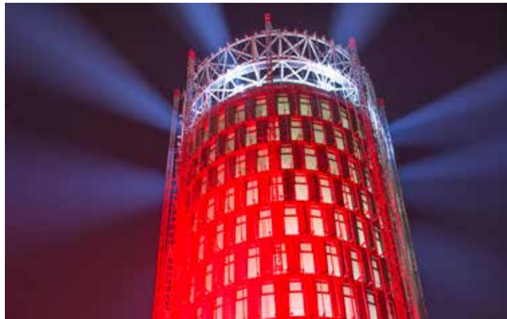
Die Lichtinstallation am Science-Tower in der Smart City Waagner-Biro-Straße
