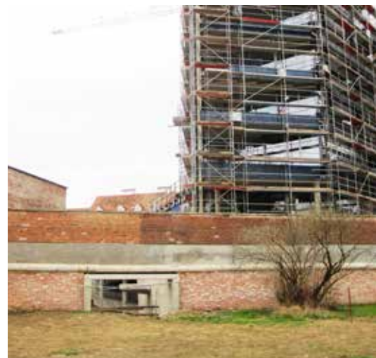
Der neue Zugang in der historischen Stadtmauer.
